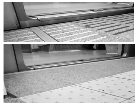
バリアフリー化したホーム 写真/横浜市
