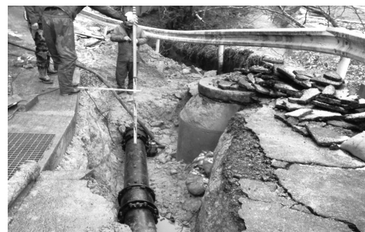
水道管の応急復旧 写真 / 横浜市
